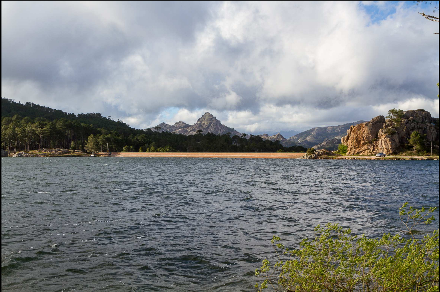
Barrage de l'Ospédale
